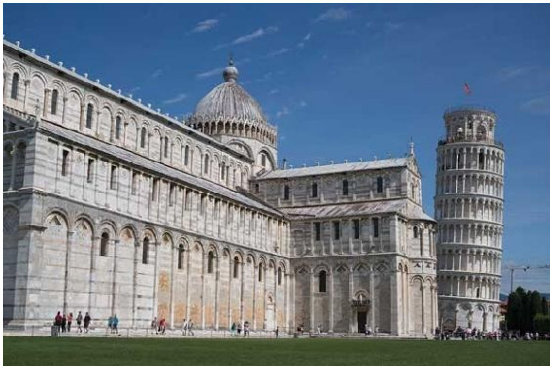
Catedral de Pisa. Aparece aquí una característica de la zona toscana que posteriormente se difundirá por otras regiones italianas y se trata del uso de un revestimiento mármoleo con bandas blancas y negras, y el empleo de unas logias superpuestas en la fachada junto con arquerías ciegas.
