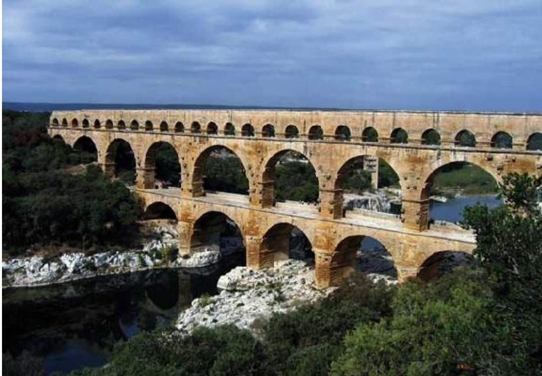
Pont du Gard. Servía para salvar desniveles y para el transporte de agua. Estaba erigido en piedra tallada y el desnivel se solucionaba con unos arcos superpuestos.
