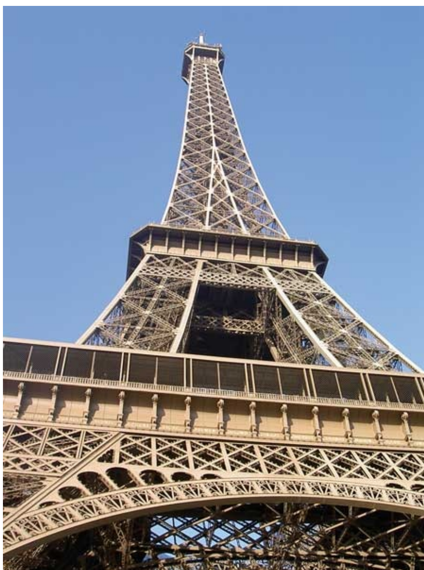
Torre Eiffel, París. La construcción de hierro más conocida y que supuso todo un alarde por su altura y perfil afilado fue la famosa torre del ingeniero Gustave Eiffel (1832-1923). Esta torre, de trescientos metros de altura, se concibió para ser desmontada, pero curiosamente permaneció y hoy día es todo un símbolo de París.
