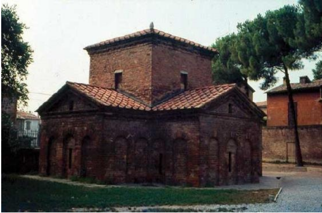
Mausoleo de Gala Placidia en Rávena. Construido a mediados del siglo V, se encontraba adosado al nártex de una iglesia. Era un edificio centralizado, de planta de cruz griega. Sus brazos estaban cubiertos por una bóveda de cañón, destacando la bóveda vaída del tramo central. Son muy interesantes los mosaicos que decoran sus bóvedas.
