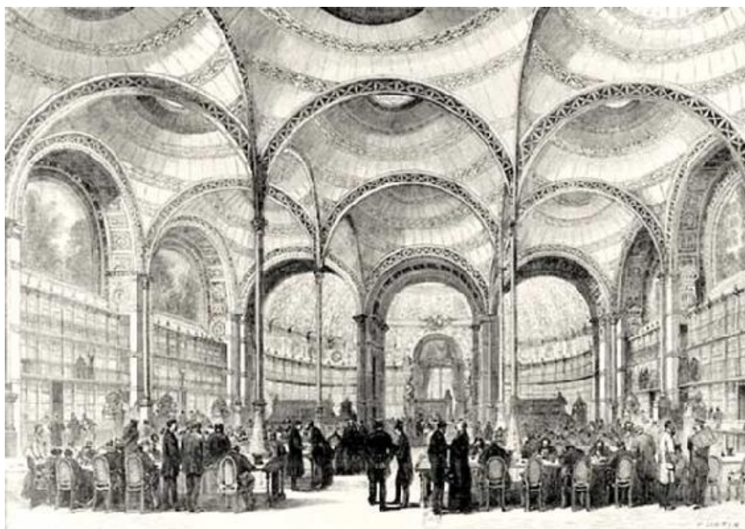
Sala de lectura de la Biblioteca Nacional de París, de Henri Labrouste. Su peculiaridad radica en sus finas columnas de hierro y capiteles decorados con motivos vegetales que sostienen una serie de cúpulas de terracota con un gran óculo que ilumina la sala. Autor: H. Linton, dessinateur.
